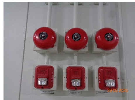
ภาพที่ 2.2-41 ลำโพงแจ้งเหตุเพลิงไหม้ (Alarm Speaker)
