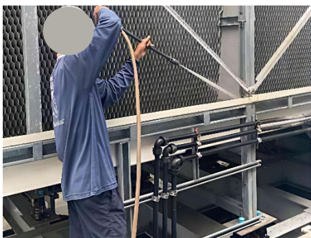
ภาพที่ 2.2-22 เจ้าหน้าที่ส่วนช่างดูแลความสะอาดในหอผึ่งเย็น (Cooling Tower)
