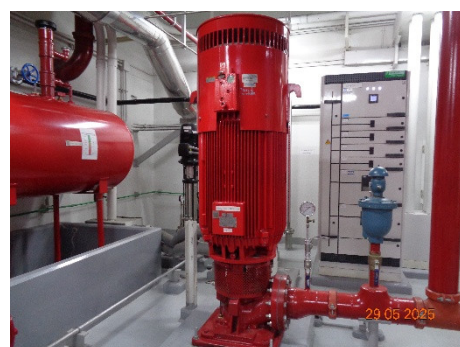
ภาพที่ 2.2-31 เครื่องสูบน้ำดับเพลิงแบบไฟฟ้า
