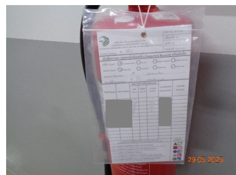
ภาพที่ 2.2-45 TAG ตรวจสอบถังดับเพลิง
